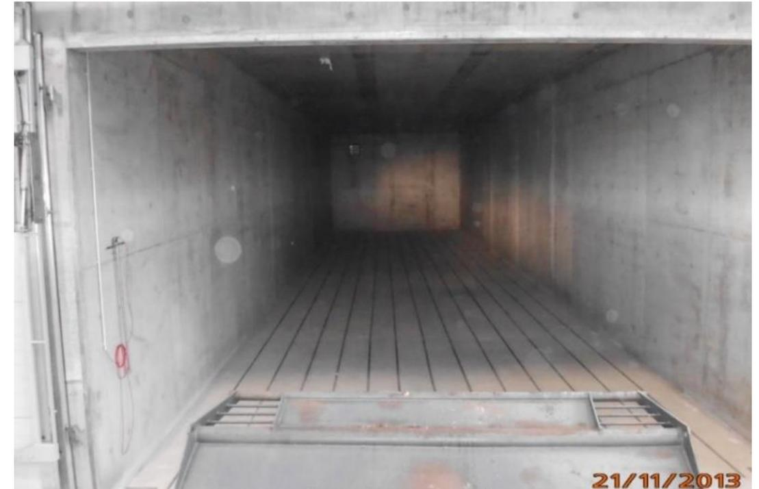
Abbildung 16: Tunnel mit Schlitzboden zur Belüftung
