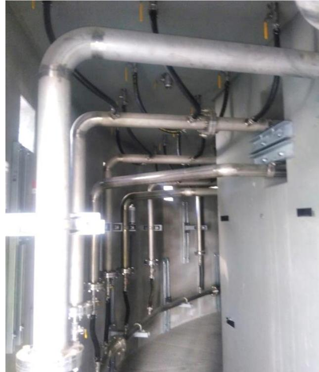
Abbildung 7: Gaseinpressung von unten in Fermenter
