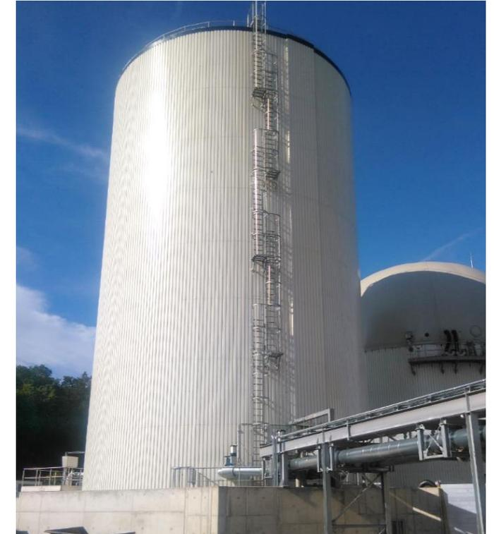
Abbildung 8: Fermenter mit 4.000m<sup>3</sup> Volumen
