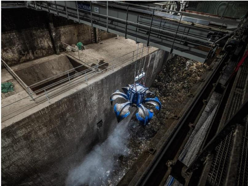
Abbildung 2: Tiefbunker für Bioabfall
